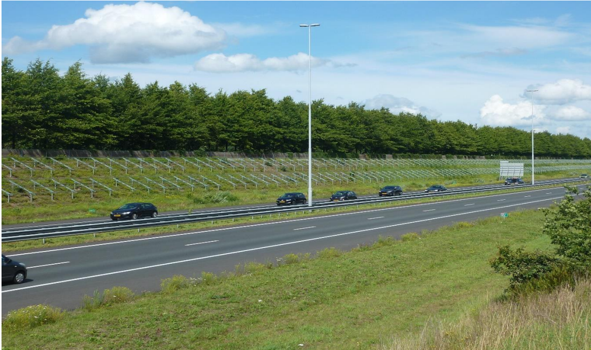
Aanleg Zonnepark A58 in uitvoering ter hoogte van Etten-Leur (© DuurSaam)
