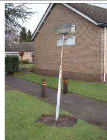
Afbeelding 11: Plaatselijk is er sprake van achterstallig onderhoud
